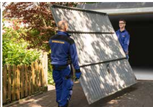
Ausbau und umweltgerechte Entsorgung
