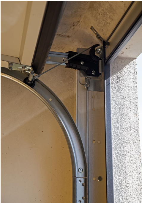
Garagen-Sectionaltor Detail Zarge / Rücklaufschiene
