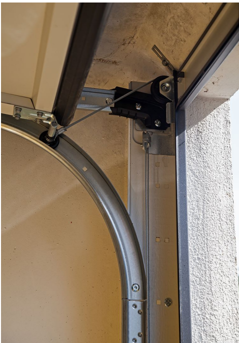
Garagen-Sectionaltor Detail Zarge / Rücklaufschiene
